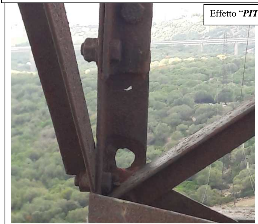
SOSTEGNO 25 Processo in atto del fenomeno corrosivo
