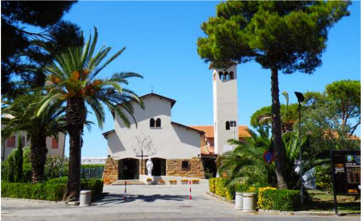
Immagine fotografica n.4 – vista della facciata della chiesa esistente
