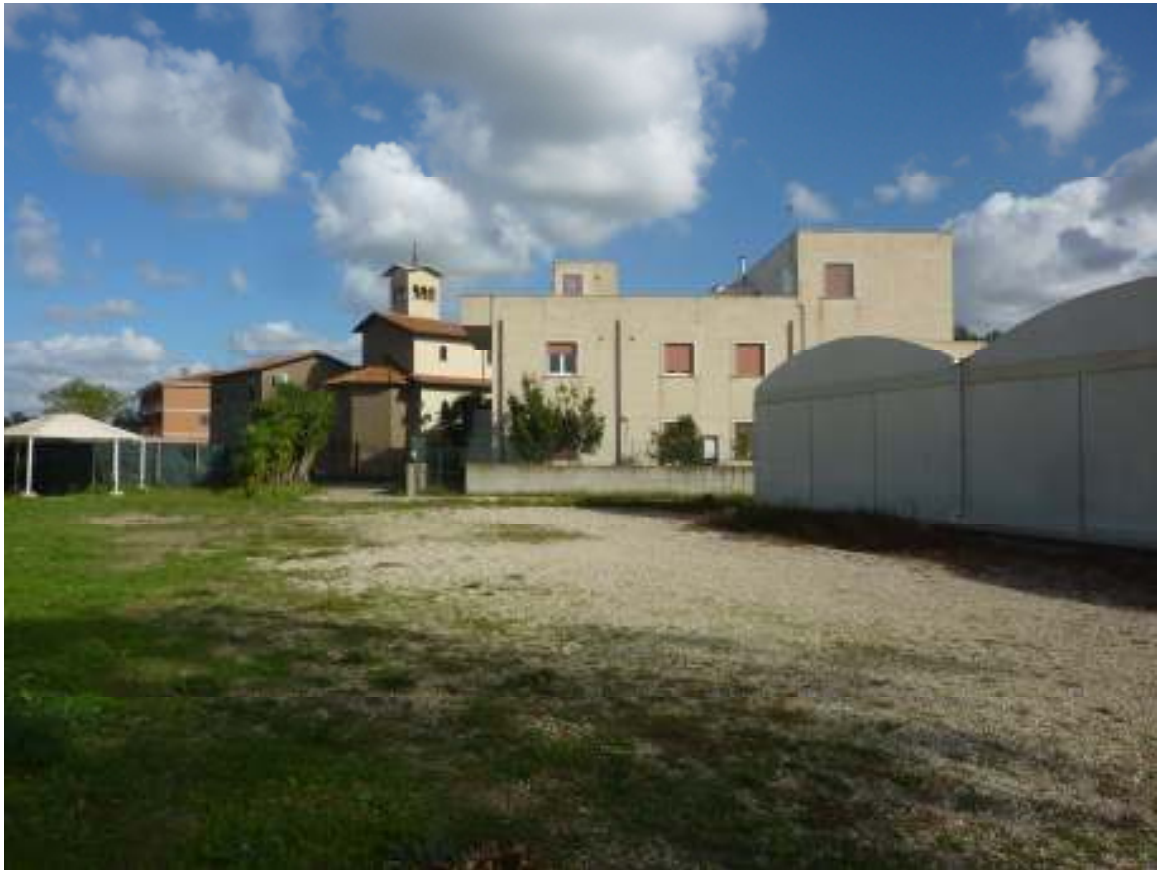
Immagine fotografica n.6 – vista del retro del complesso
