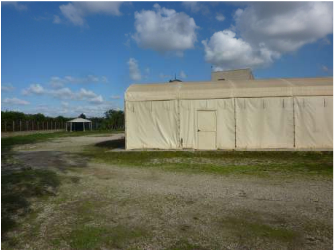
Immagine fotografica n.5 – vista della struttura tensotesa
