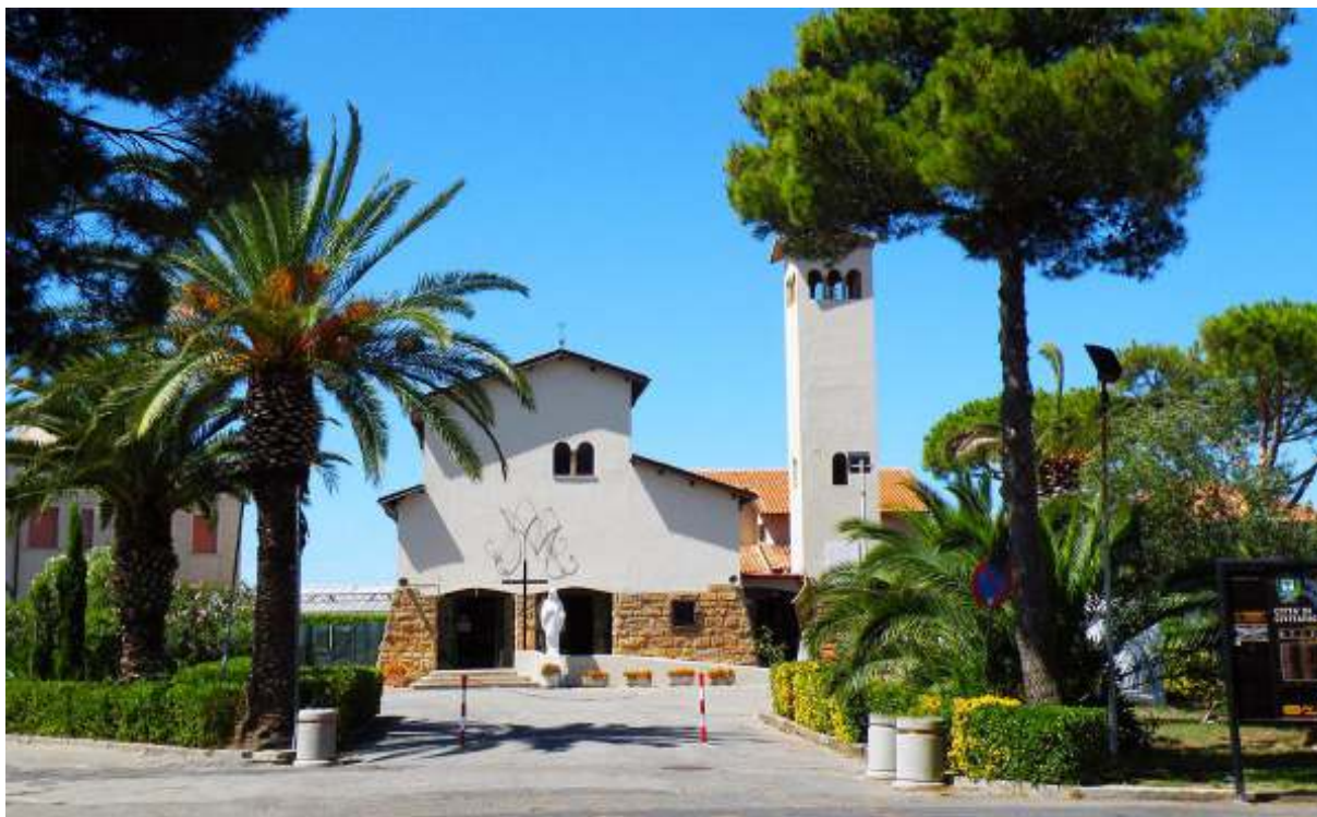
Immagine fotografica della chiesa attualmente presente nell'area d'intervento
